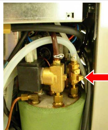
Montieren Sie das mitgelieferte 2-Wege-Magnetventil und halten Sie die Spule auf der inneren Seite.
